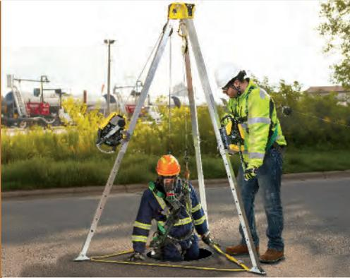
Для доступа в ограниченные пространства без точек опоры компания MSA предлагает уникальную систему спуска/подъема персонала и груза. Универсальная тренога обеспечивает анкерную точку крепления класса В. Подъем осуществляется с помощью лебедки MSA Workman. Самовтягивающиеся стропы служат в качестве устройств замедления падения. Спасательная лебедка MSA Workman Rescuer обеспечивает оперативную, простую и интуитивно понятную защиту от падения с высоты с возможностью двунаправленного извлечения.
